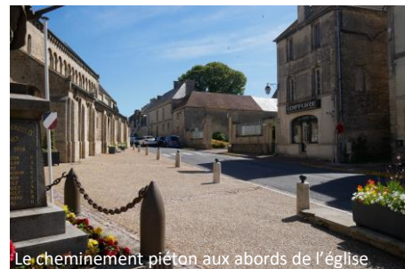
Le cheminement piéton aux abords de l'église
