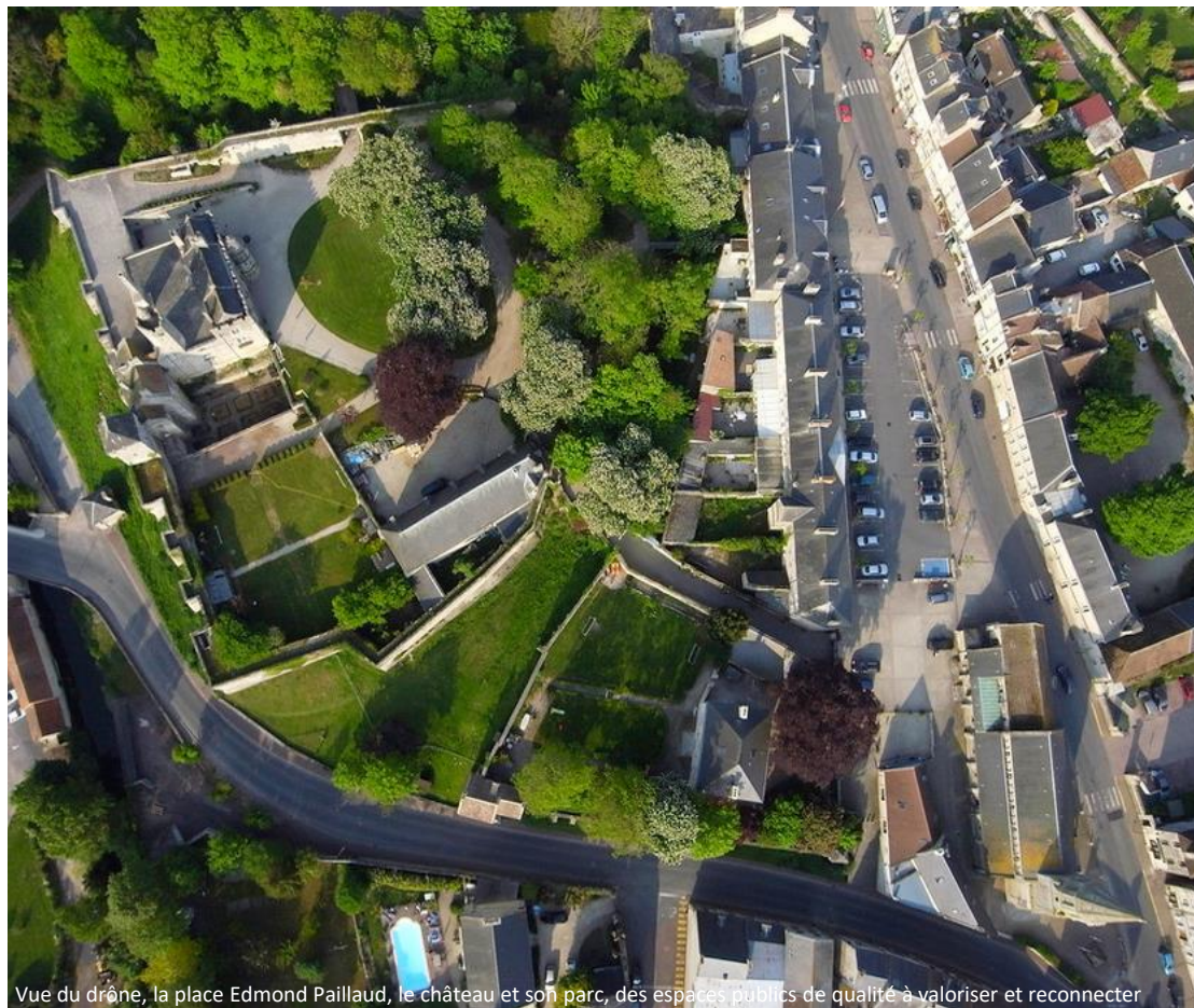
Vue du drone, la place Edmond Paillaud, le château et son parc, des espaces publics de qualité à valoriser et reconnecter
