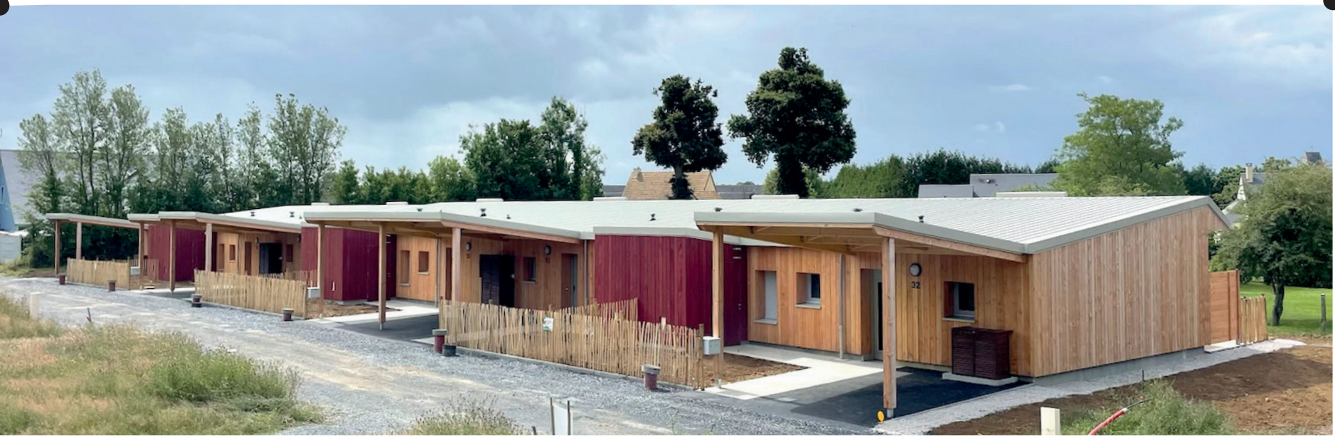
Façade sur la future rue au nord-est lors de la livraison du chantier.
